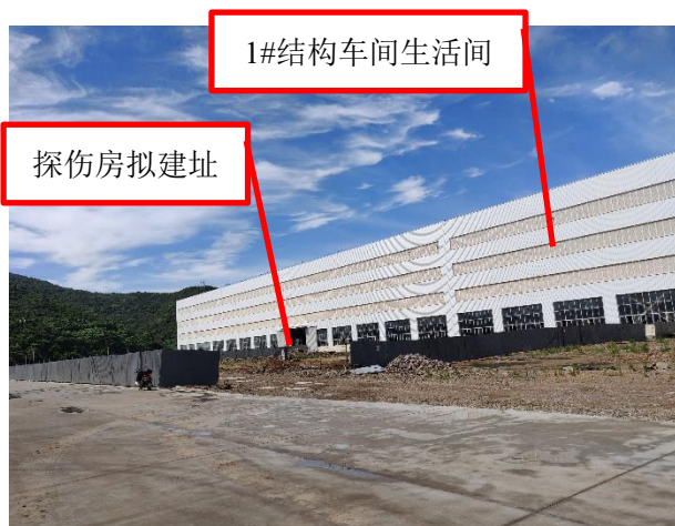
图 1-1 探伤房拟建址及西侧
