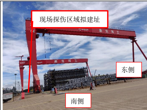
图 1-5 现场探伤区域拟建址及东侧、南侧
