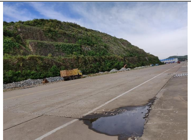
图 1-6 现场探伤区域拟建址南侧道路及山丘
