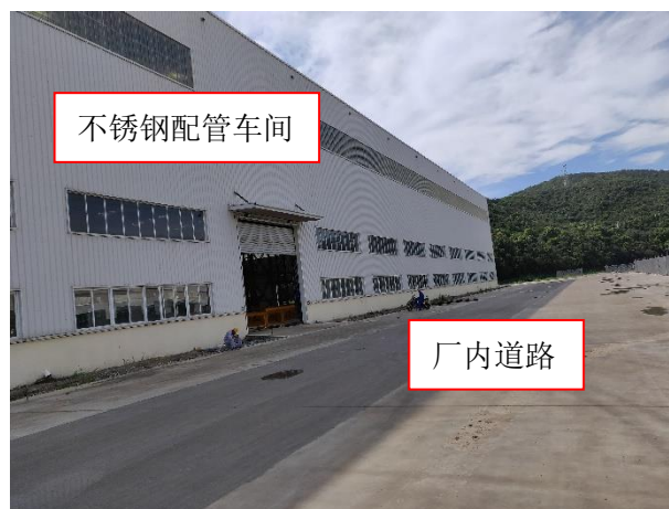
图 1-2 探伤房拟建址东侧
